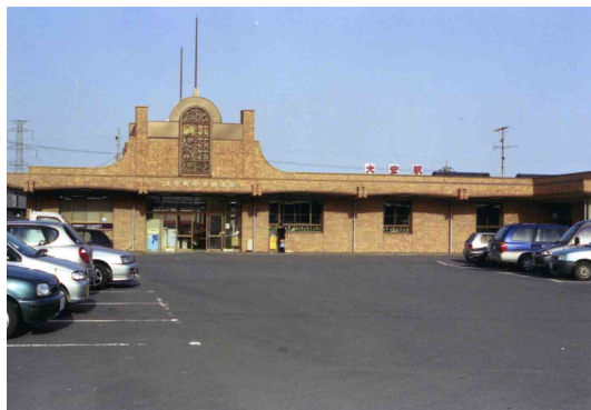
いなべ市：市立図書館を三岐鉄道大安駅に併設
