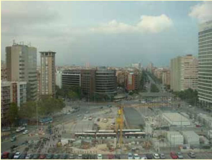
急ピッチで進む駅前広場整備
